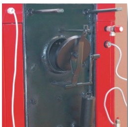
Sistem cu clapetă pentru evacuarea gazelor arse
